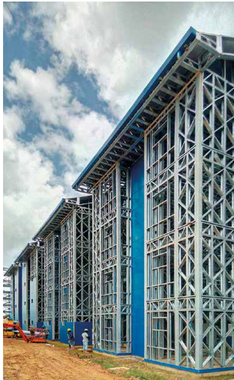
ASSEMBLAGGIO DEI PANNELLI E FISSAGGIO ALLE STRUTTURE
