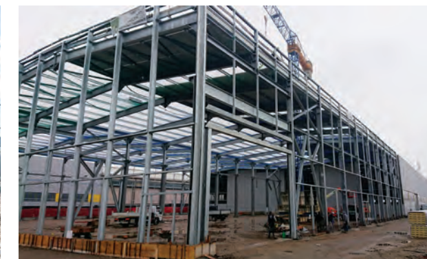
Vista delle colonne e delle strutture portanti dell'ampliamento: sullo sfondo l'edificio esistente
