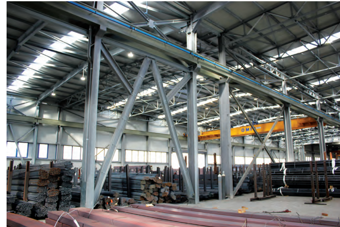
Vista interna: particolare del giunto sismico
