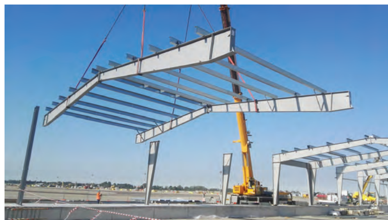
Posa delle travi di copertura sulle colonne.
