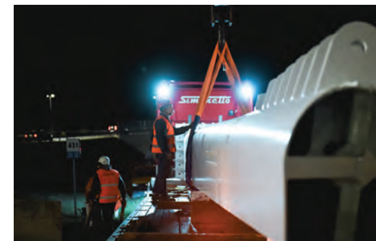
Posa dell'impalcato e dell'antenna nelle ore notturne
