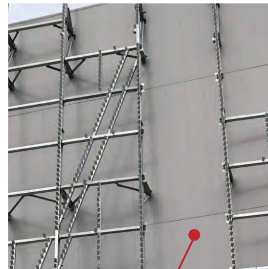
La struttura in acciaio zincato atta a sostenere il rivestimento
