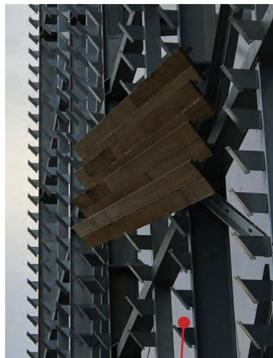
Installazione delle doghe lignee sulle mensole in acciaio zincato
