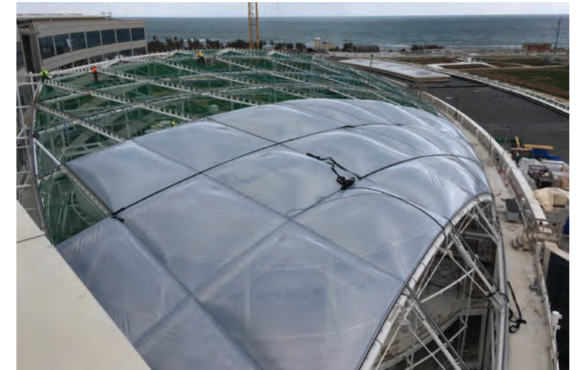
Dettaglio aggancio copertura in etfe.
