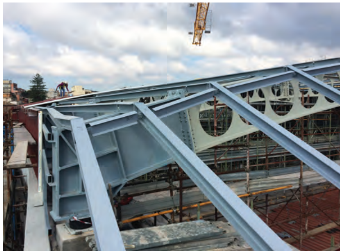
Dettaglio profili secondari e appoggio della trave principale su isolatori elastomerici.
