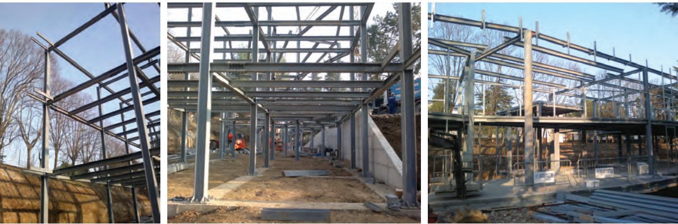
Le strutture portanti in acciaio zincato, assemblate con tecnologia costruttiva a secco, hanno permesso altissime prestazioni di risparmio energetico e contenimento dei costi di costruzione.
