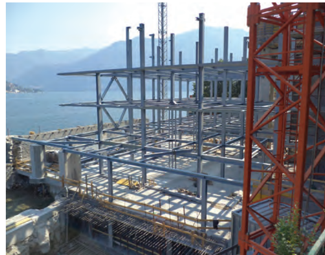
Fasi di cantiere: la struttura portante interamente in carpenteria metallica.
