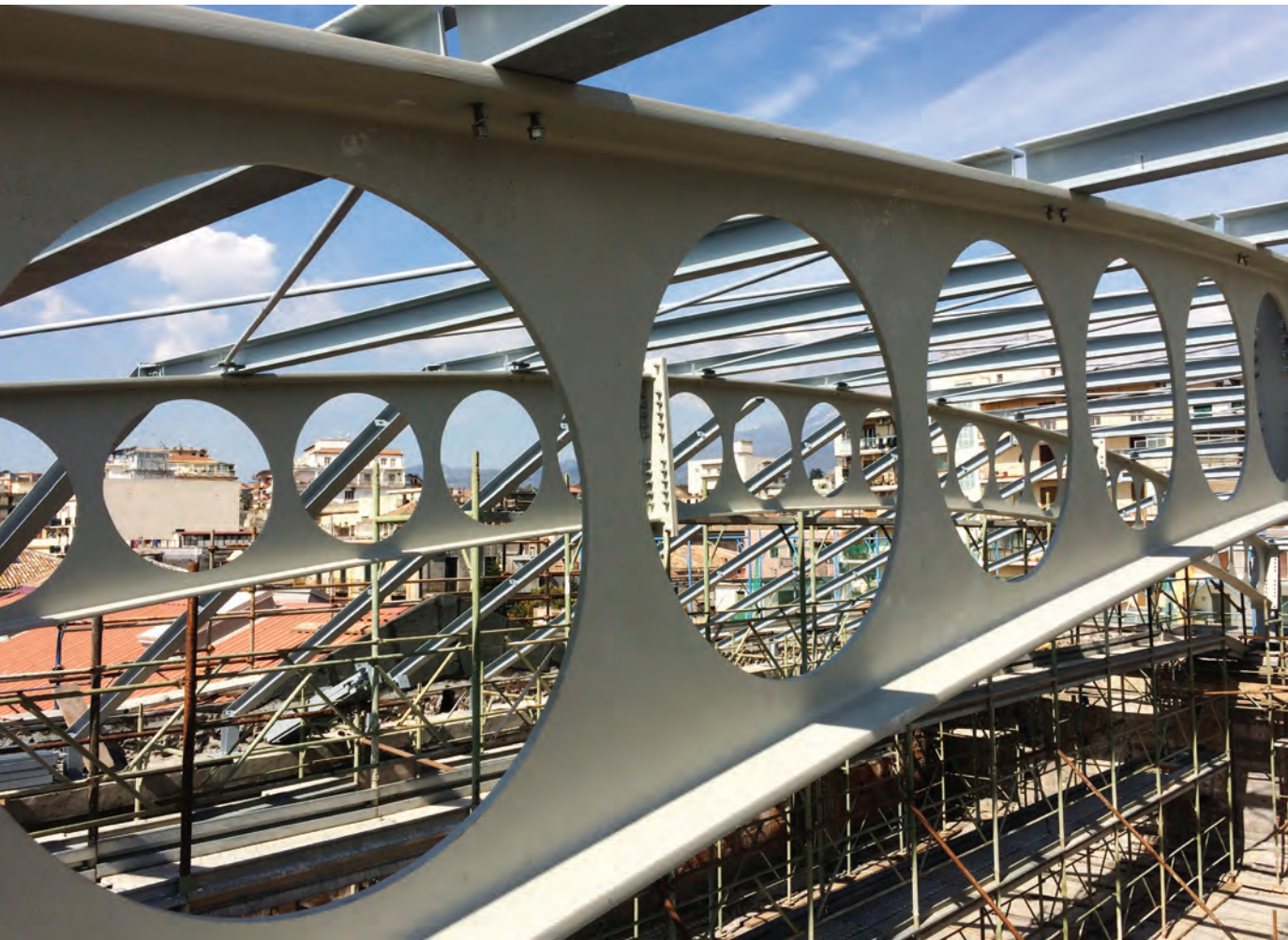
Dettaglio delle travi alveolari di copertura.
