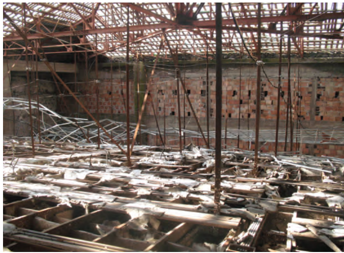
Stato pre-intervento: le capriate metalliche originarie riuscirono a ripartire le resistenze, impedendo il totale crollo della copertura e del controsoffitto.
