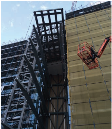
Fasi di cantiere: posa in opera dei portali d'ingresso in carpenteria metallica, montaggio dei rivestimenti.
