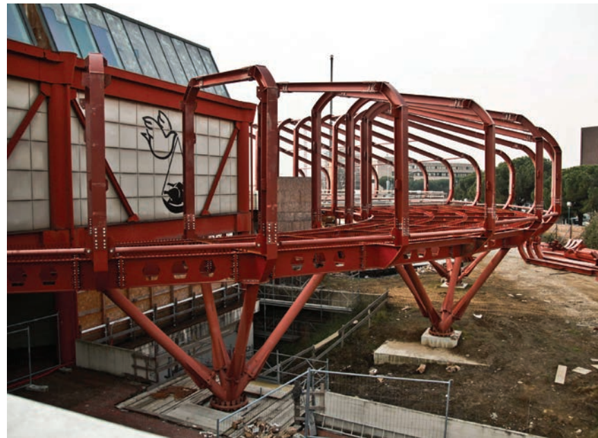
Cantiere: le strutture in acciaio che circondano la preesistenza, vista generale.
