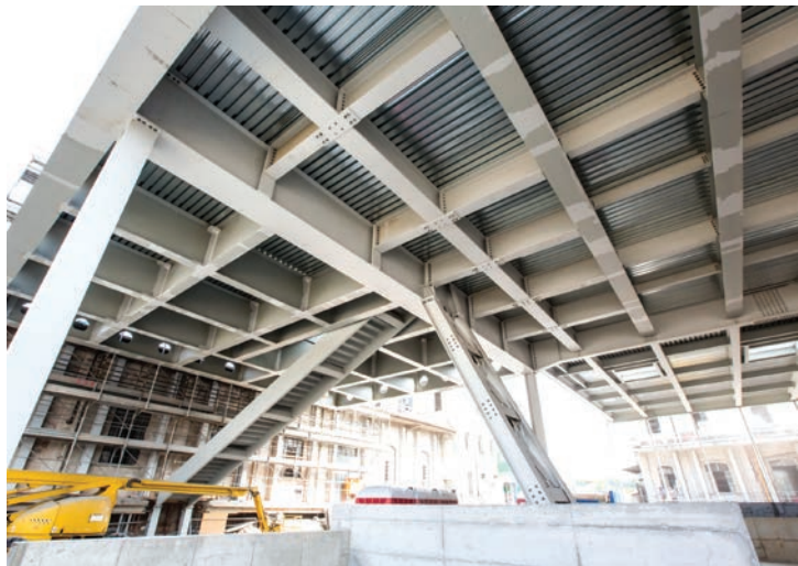
Dettaglio delle travi e del solaio d'interpiano in lamiera grecata.
