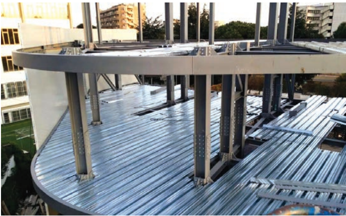
Sequenza di cantiere: posa delle strutture metalliche, realizzazione dei solai in lamiera grecata, montaggio dei pannelli sandwich di tamponamento.
