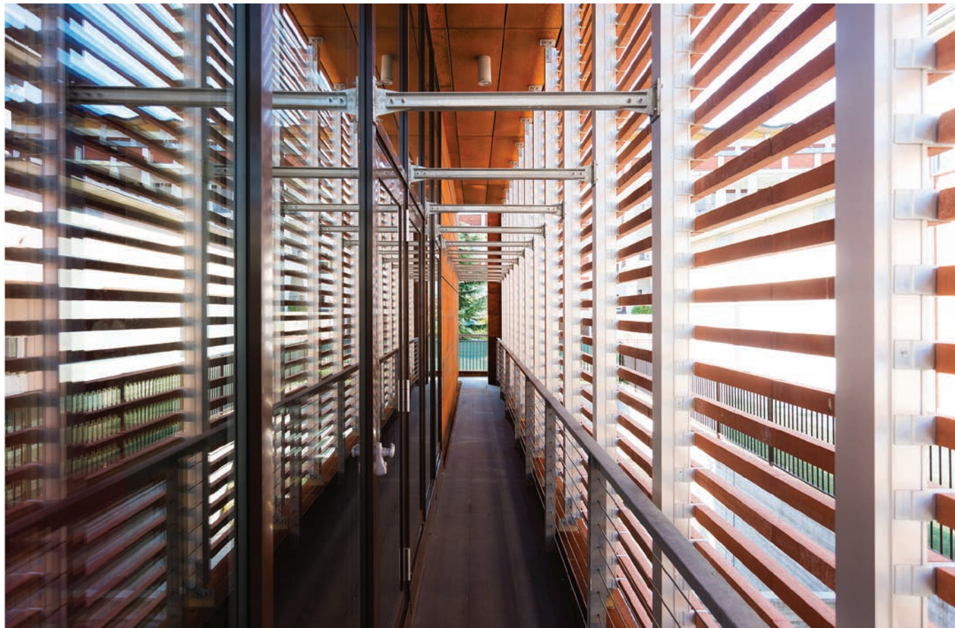
SOPRA Dettaglio dei supporti dei frangisole e dei parapetti in acciaio zincato.
