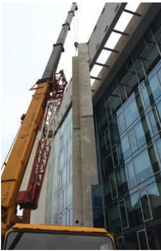
Fasi di cantiere: posa in opera dei portali d'ingresso in carpenteria metallica, montaggio dei rivestimenti.
