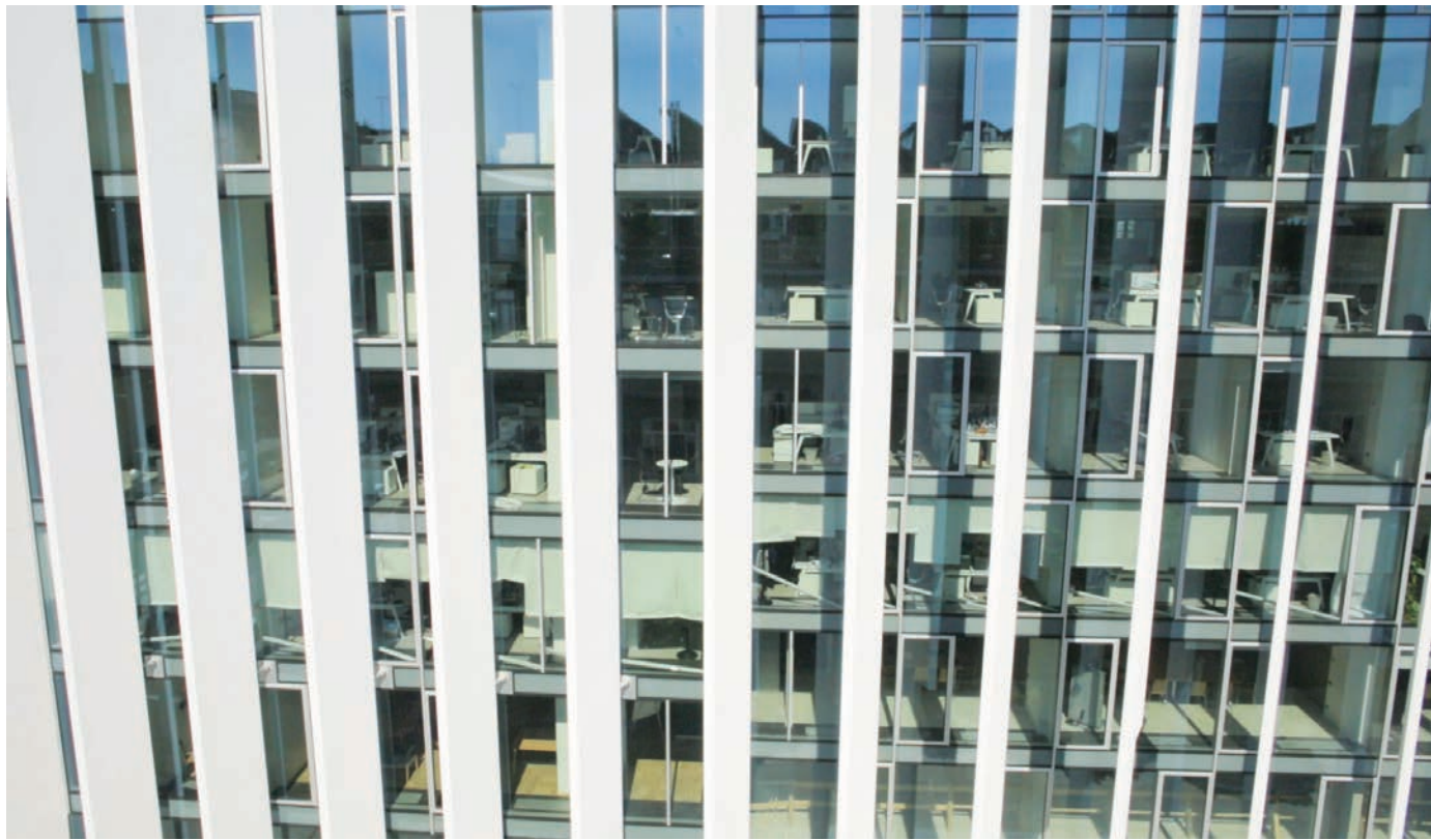
Dettaglio dei frangisole in elementi scatolari in acciaio, che raggiungono la ragguardevole altezza di 32 metri.
