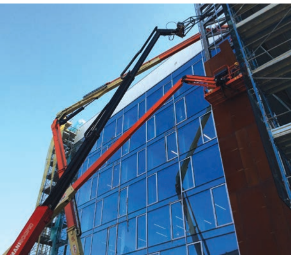
Fasi di cantiere: posa in opera dei portali d'ingresso in carpenteria metallica, montaggio dei rivestimenti.
