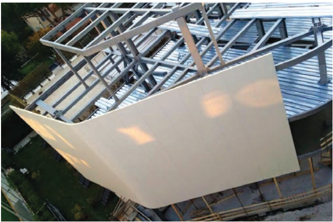
Sequenza di cantiere: posa delle strutture metalliche, realizzazione dei solai in lamiera grecata, montaggio dei pannelli sandwich di tamponamento.
