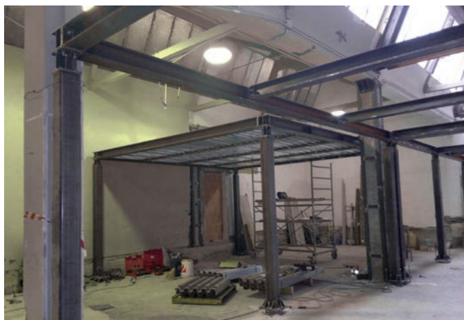
Vista degli elementi in acciaio di rinforzo e del soppalco.
