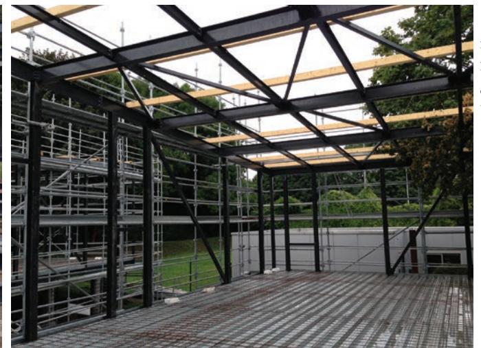
SOPRA Vista di cantiere dei nuovi padiglioni sospesi in acciaio, innestati sull'edificio esistente.
