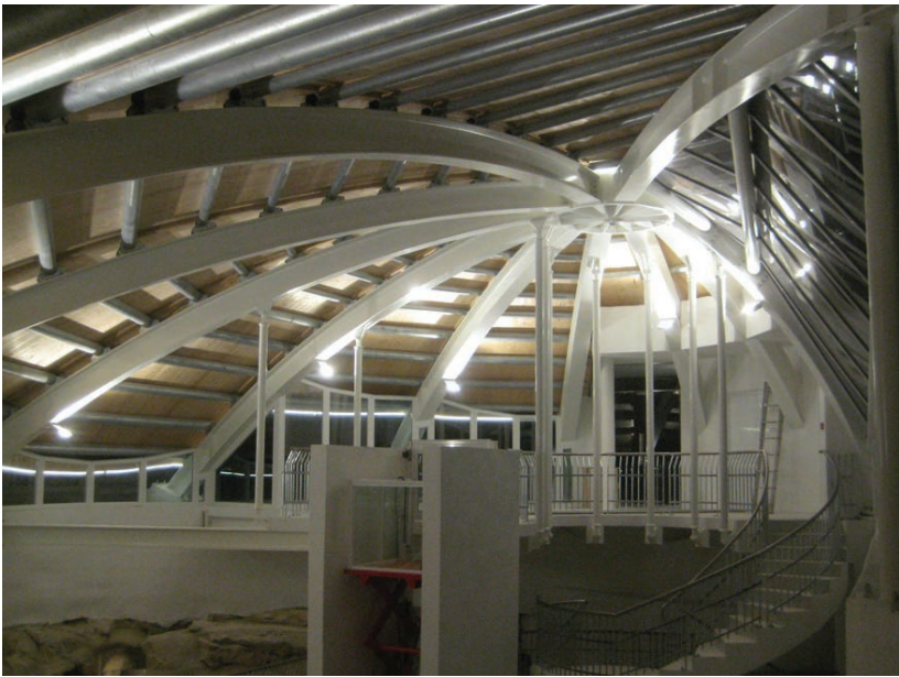
IN SENSO ORARIO La "chiocciola" a cantiere ultimato, 3D di progetto, dettaglio dell'anello di congiunzione delle travi in acciaio.
