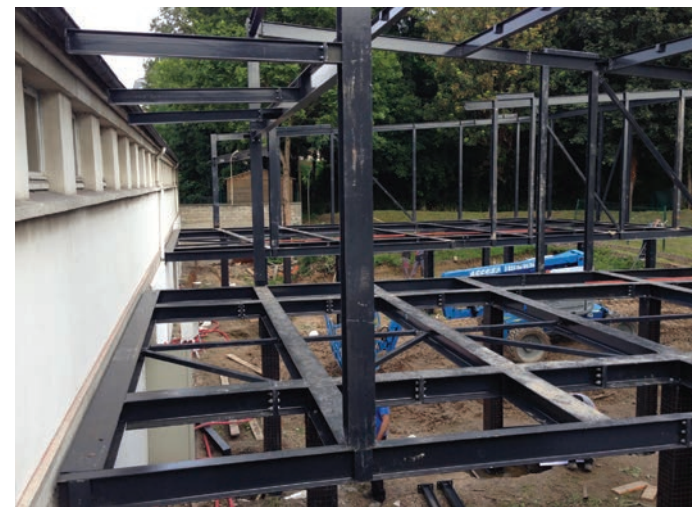
A SINISTRA I padiglioni in acciaio, sopraelevati come palafitte, e rivestiti in lamiera di zinco e acciaio inossidabile.
