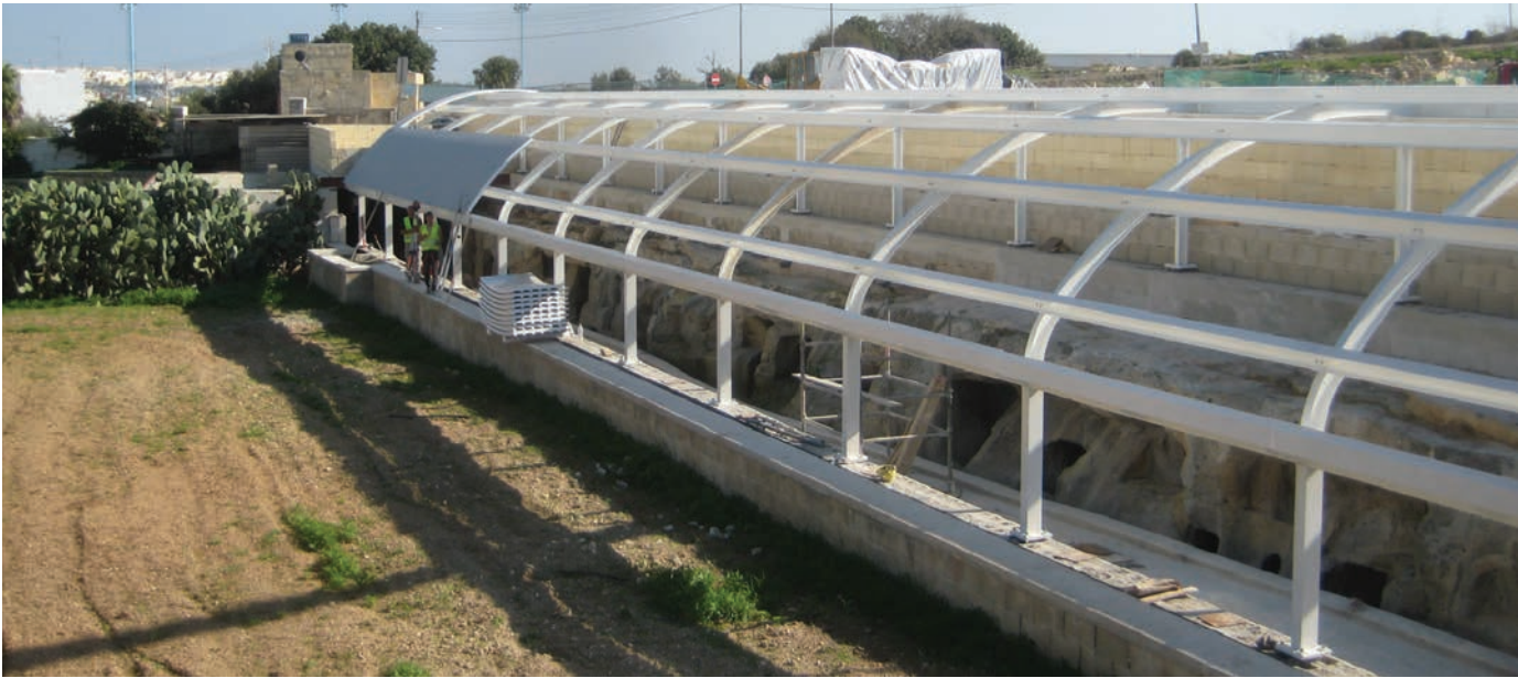
Vista della "walkway" e delle strutture portanti in acciaio durante la posa dei pannelli sandwich di copertura.
