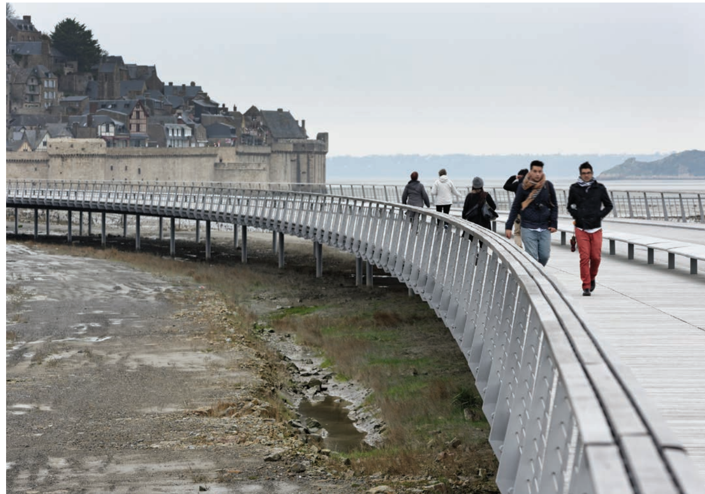
PAGINE SUCCESSIVE I sottili tubolari in acciaio che sostengono l'impalcato riducendo al minimo i depositi lasciati dalle maree.
