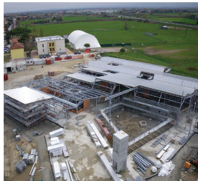
Fasi di cantiere del polo scolastico, realizzato con tecnologia stratificata a secco in acciaio.
