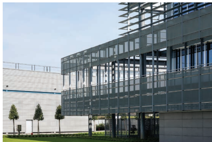
SOPRA E A FIANCO Dettaglio dei rivestimenti in lamiera microforata su struttura di sostegno in acciaio del palazzo uffici e servizi.
