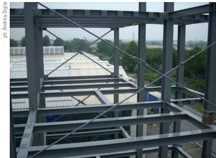
Vista delle strutture portanti interamente in acciaio e dei tamponamenti interni del ristorante in fase di cantiere.
