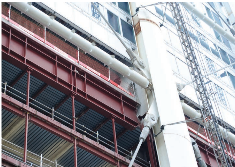
Vista 3D e dettagli in fase di cantiere di una megacolonna.
