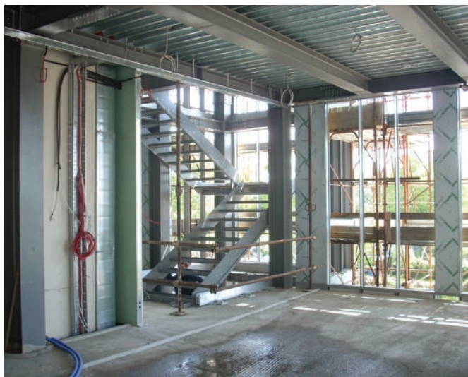
Vista delle strutture portanti interamente in acciaio e dei tamponamenti interni del ristorante in fase di cantiere.
