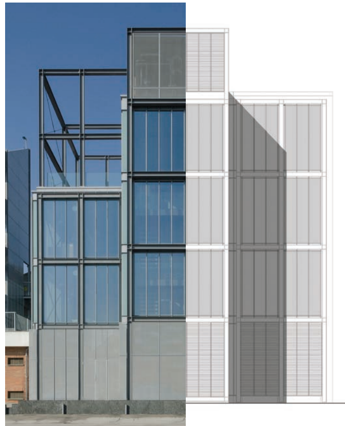
Sia all'esterno che all'interno gli elementi portanti e di rivestimento in acciaio sono stati lasciati a vista.
