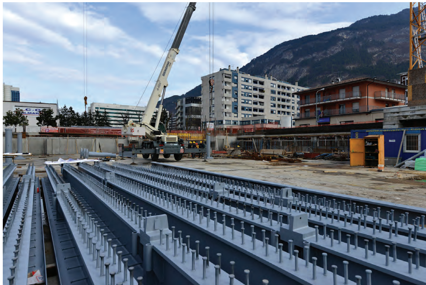
Posa delle colonne tubolari e delle travi composte in acciaio del primo piano.
