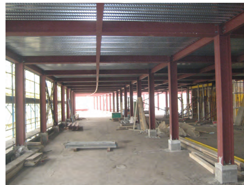
Vista delle strutture in acciaio della sopraelevazione e del corpo ellittico.
