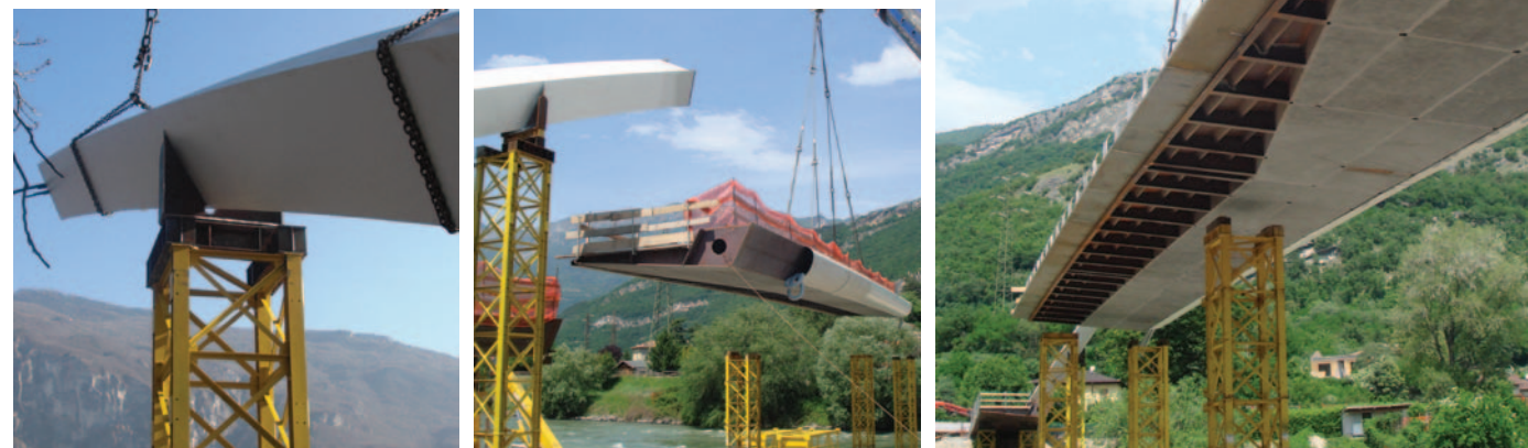
SOTTO Fasi di montaggio dell'arco e dell'impalcato del ponte.
