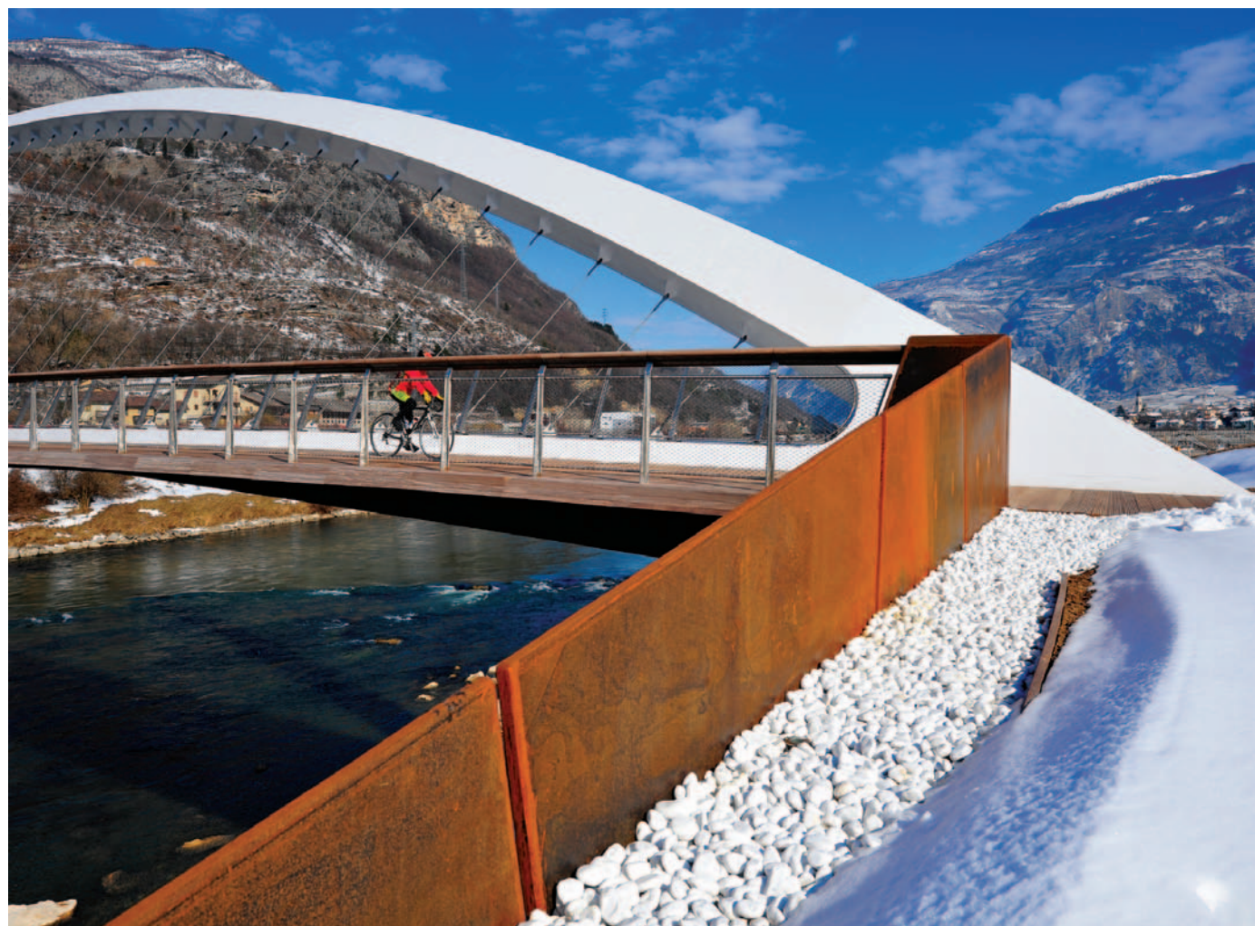
IN QUESTA PAGINA Viste 3D della passerella. Contrasto tra il bianco dell'arco ed il colore bruno delle lamiere in acciaio corten.
