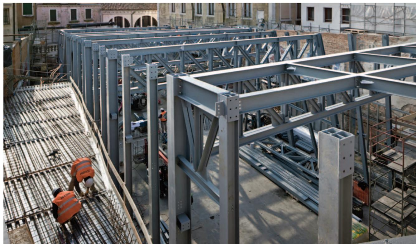
Fasi di cantiere: stato di fatto prima dell'intervento, montaggio dell'ossatura in carpenteria metallica e dei solai in lamiera grecata in acciaio.
