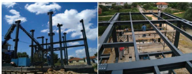
La struttura portante dell'edificio è costituita da un telaio in acciaio, con tamponature a secco.
