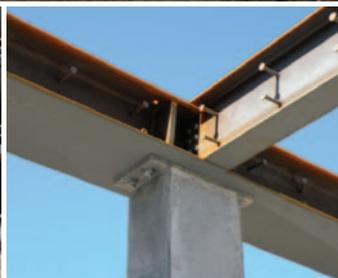
SFB costituite da profili H ai quali sono saldati, sotto l'ala inferiore, piatti sporgenti a sbalzo che sostengono i pannelli di solaio in fase di costruzione. I profilati sono dotati di connettori a piolo, saldati sull'anima, che hanno il duplice scopo sia di contrastare lo scorrimento tra l'acciaio strutturale e il calcestruzzo di completamento gettato in opera, sia di impedire fenomeni di instabilità delle lastre che rivestono l'anima. Gli elementi
