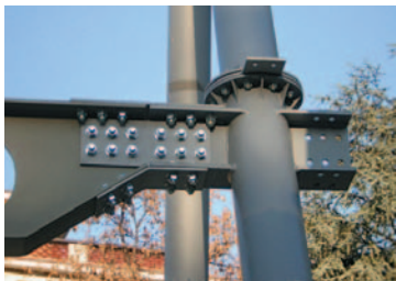
IN ALTO Le colonne inclinate e le travi alveolari durante la fase di montaggio della carpenteria metallica. SOPRA, DETTAGLI Dettaglio di connessione trave colonna e attacco a terra. (Tutte le foto di cantiere sono di Buonomo Veglia - Areaprogetti)
