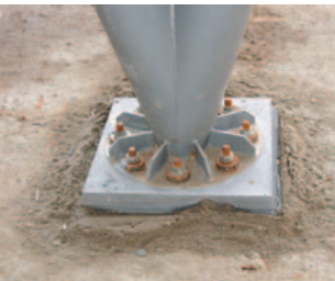
IN ALTO Le colonne inclinate e le travi alveolari durante la fase di montaggio della carpenteria metallica. SOPRA, DETTAGLI Dettaglio di connessione trave colonna e attacco a terra. (Tutte le foto di cantiere sono di Buonomo Veglia - Areaprogetti)
