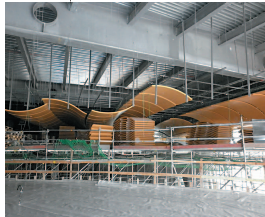
I controsoffitti durante la fase di montaggio.
