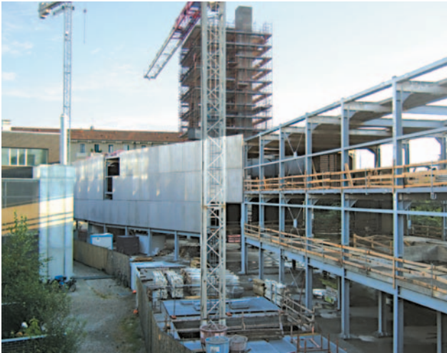
L'edificio in fase di cantiere e a cantiere ultimato.
