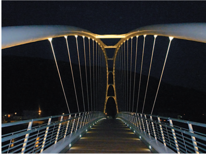
PONTE CICLOPEDONALE S.MICHELE ALL'ADIGE
