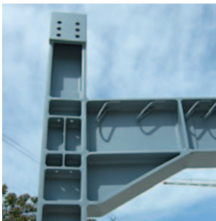
Dettagli strutturali dei nodi e vista di un nodo trave-colonna in fase di cantiere.
