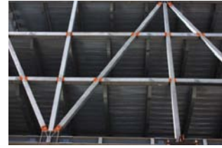
La trave reticolare di facciata a sostegno dell'intero edificio
