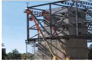
Montaggio della carpenteria metallica →
