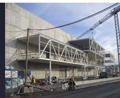
Il montaggio quasi ultimato delle strutture in acciaio [ph. Lissoni Associati]
