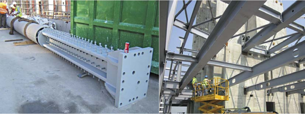
DA SINISTRA: la colonna composta in attesa della posa / Montaggio della carpenteria di piano
