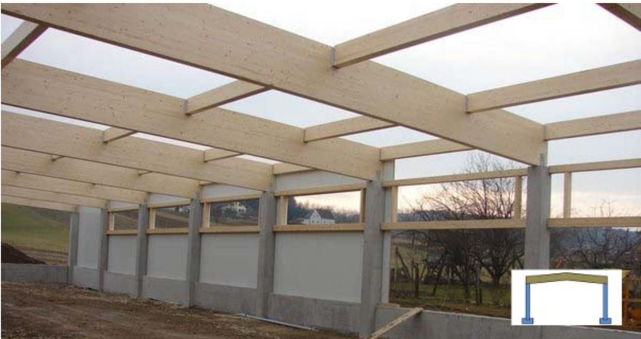
Figura 7: Edificio monopiano con telaio legno/calcestruzzo (c.a./Legno) e relativo simbolo
