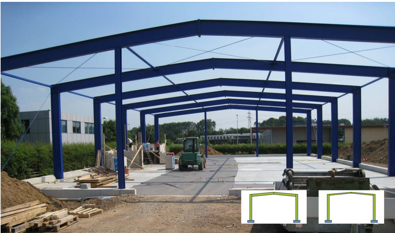
Figura 4: Edificio monopiano con telaio in acciaio e relativi simboli per acciaio S235 (a sinistra) ed S460 (a destra)
