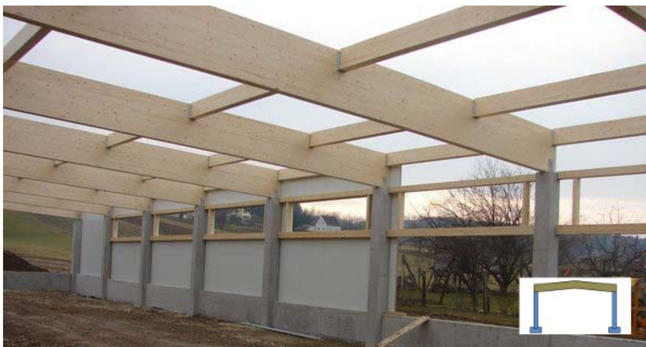
Figura 7: Edificio monopiano con telaio legno/calcestruzzo (c.a./Legno) e relativo simbolo
