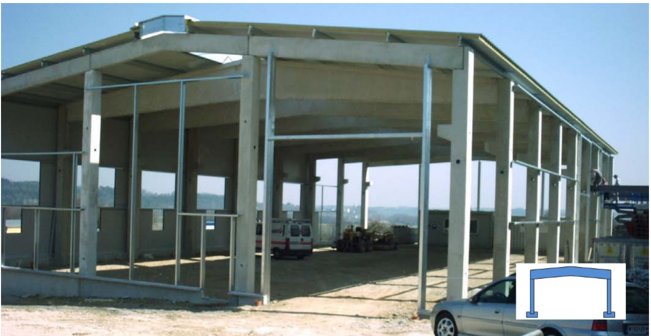
Figura 6: Edificio monopiano con telaio in calcestruzzo armato prefabbricato (RC) e relativo simbolo
