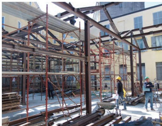
2 - Posa delle strutture in carpenteria metallica
