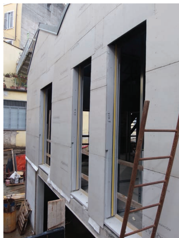
4 - Installazione degli involucri a secco di parete
