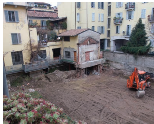
1 - Scavi e opere di consolidamento mediante micropali
