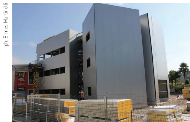
Vista dell'involucro in pannelli sandwich
