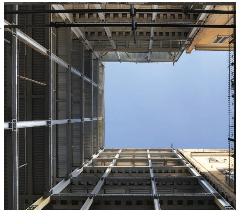
Vista delle strutture in acciaio in cantiere e a progetto ultimato (fasce marcapiano)
