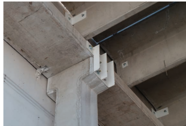
3 - Inserimento di elementi in carpenteria metallica per connettere travi-colonne e travi-tegoli
