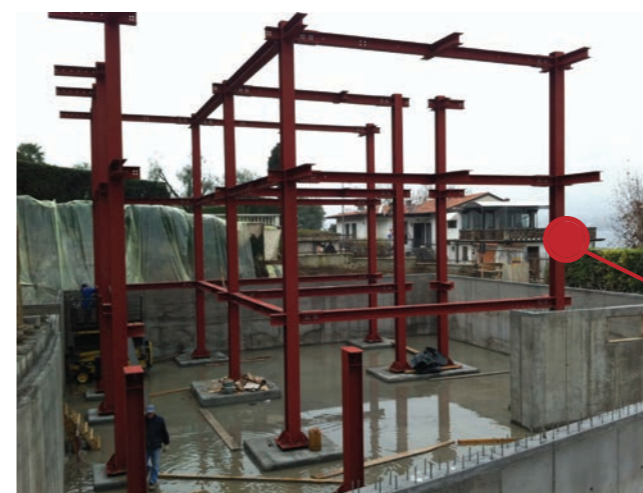
Strutture portanti in carpenteria metallica
