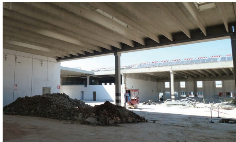
2 - Svuotamento dell'area centrale del capannone per ricavare il patio
