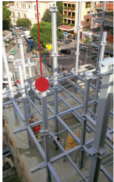
Strutture in acciaio in elevazione
