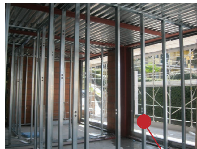
Partizionamento interno con tecnologia stratificata a secco
