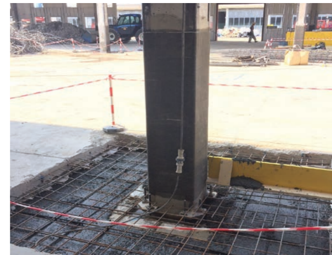
4 - Rafforzamento delle colonne e dei plinti di fondazione
