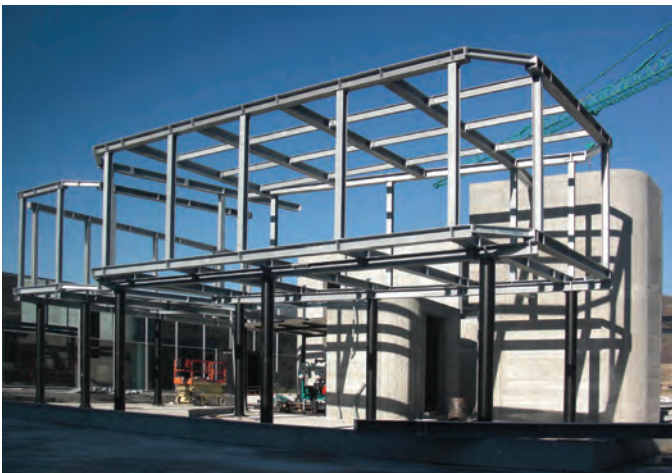
Struttura in acciaio di un blocco direzionale.
