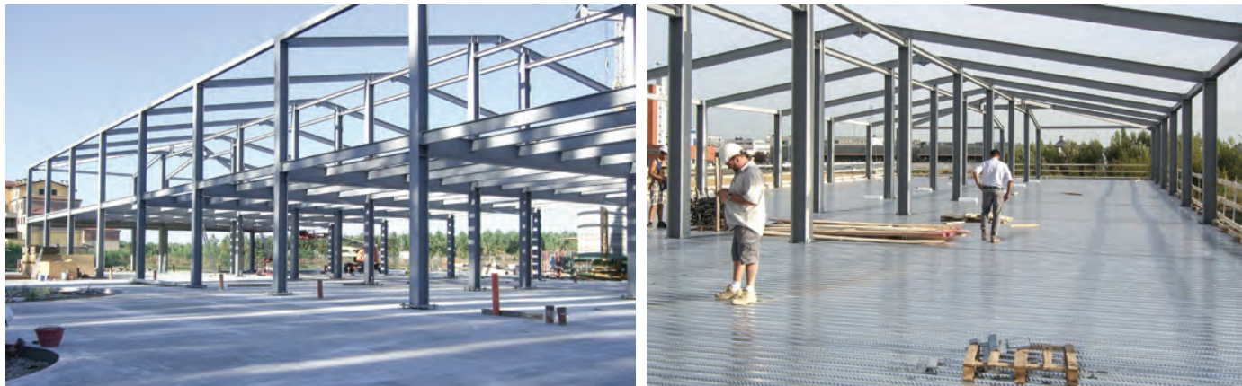
SOPRA Vista delle strutture in acciaio in fase di cantiere e del solaio d'interpiano in lamiera grecata.
