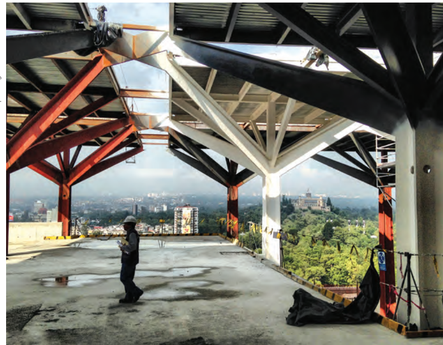
Vista delle megacolonne interne e degli elementi a "V" rovescia esterni.
